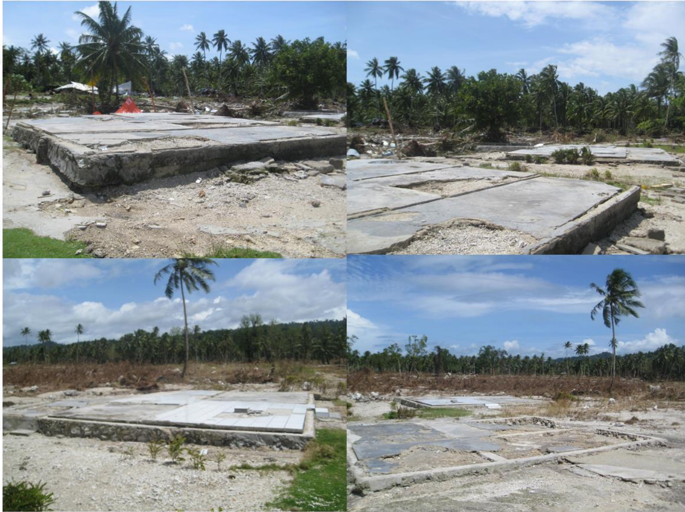
Sebuah desa yang rata setelah disapu tsunami. Bangunan rumah umumnya hanya tersisa bagian pondasi/tapak saja. Dinding tembok dan atap umumnya hancur dan hanyut. (BMKG, 2010)
