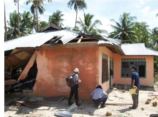
Sebuah rumah penduduk yang sebagian rusak diterjang tsunami (BMKG2010)
